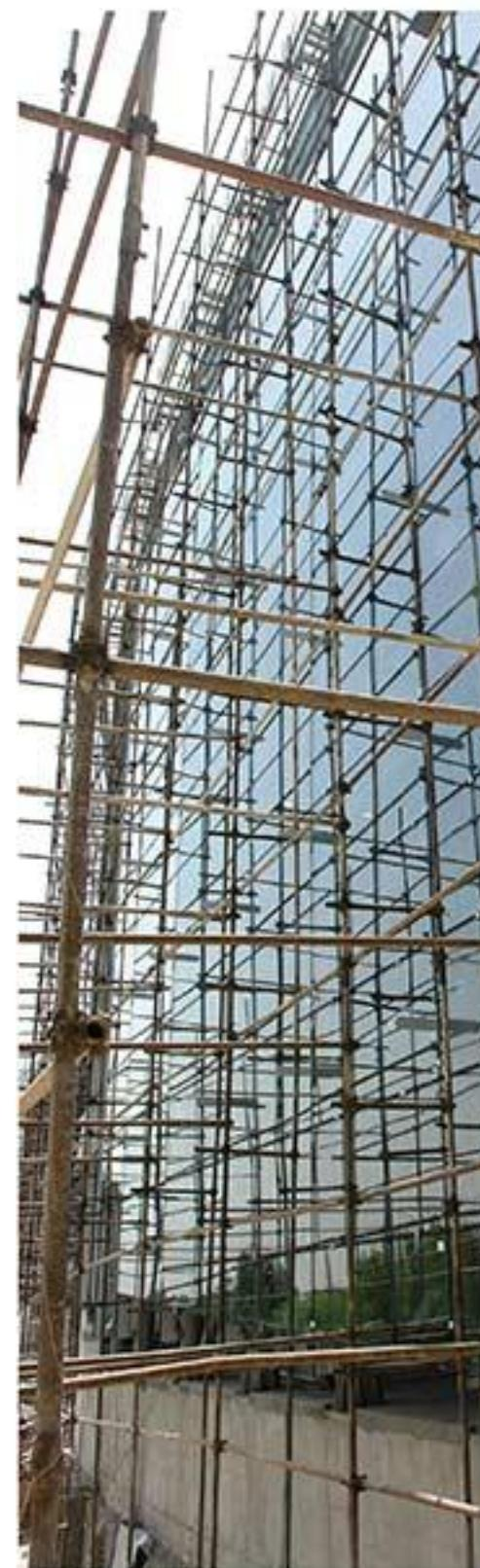
داربست سنتی از اتمال لوله‌های داربستی به قطر ۵ سانتیمتر در طول‌های مختلف و بسته‌های چهار پیچ تشکیل می‌گردد . در زیر جزئیات هر یک فشنگش شده است .
